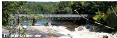
Chute de la cheminée
